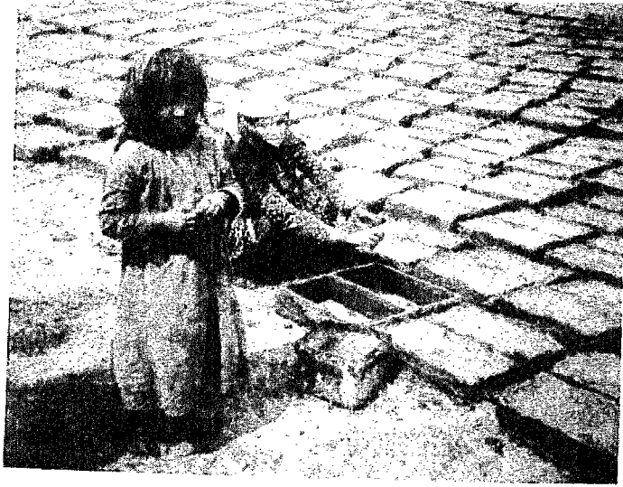
الشكل رقم ٧٢: في قرى العراق مازالوا يصنعون القرميد من الطين المعالج بالقش والمصبوب بقالب خشبي بدون قعر. يتم صقل السطح والتنظيف في أشعة الشمس.
